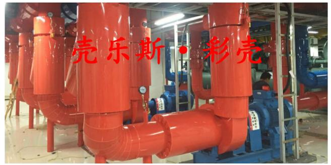
上海赛洛林工程材料科技有限公司的壳乐斯PVC保温外护,安装管帽或封堵时,小尺寸的管帽是椭圆型的,安装时只需将管帽从中间对半剪开,但在边缘处不要剪断,这样方便调节管帽的大小,依据管道外径大小用剪刀按照需要剪成圆,同时将管帽边缘搭接部分剪成花瓣,稍向内折一下,缠上双面胶带,然后安装在需要处的直管内壁(即直管盖住管帽),对齐合拢时撕去双面胶带的外层纸并固定好,再跳点胶水即可。管径尺寸相配的圆形管帽,则不需要从中间剪开,只要将管帽边缘搭接部分剪成花瓣,稍向内折一下,缠上双面胶带,然后安装在直管内壁,对齐合拢时撕去双面胶带的外层纸并固定好,再跳点胶水就可以了。操作起来非常方便。
