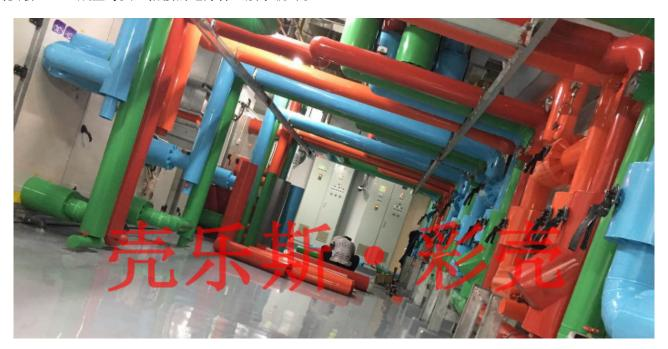
壳乐斯·彩壳PVC保温外壳,不仅起到美观整洁的作用,同时还能对内部的保温材料起到保护作用。
